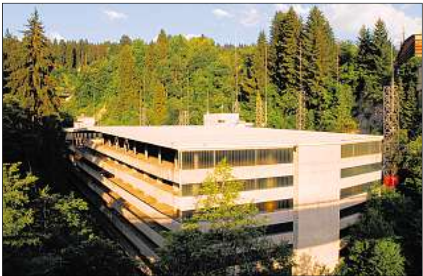
La casa da parcar vegn a restar el liug. Sin lezza vegnan duas casas cun 137 habitaziuns baghegiadas. Avon ston las autoritads denton s'occupar dils recuors ch'ei gest entrai.
